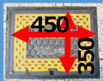
埋設ボックスの内径寸法が横450mm×縦350mmの場合、上記の通りの設置イメージとなります。
